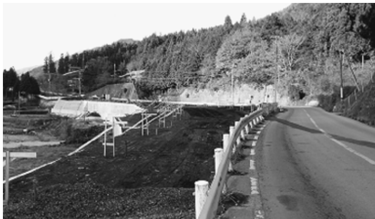
国道改良:釜之前地内
