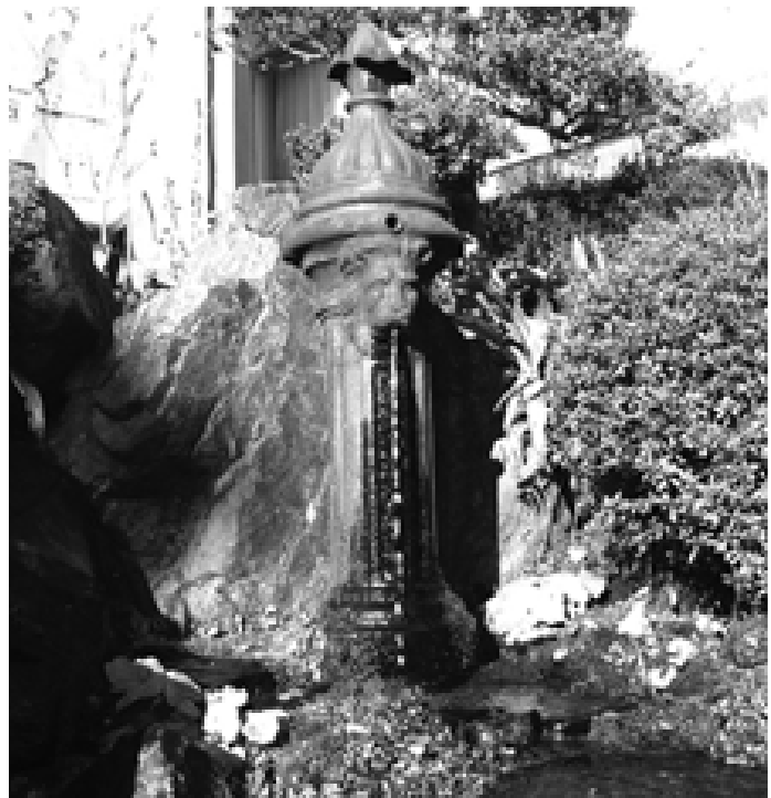
道志村役場前:横浜市内の随所に設置されていた「獅子頭共用栓」
